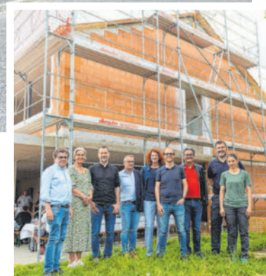
Die Firstfeier des Neubaus hat schon stattgefunden.
